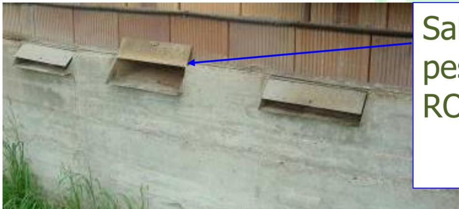
Salida de aire, posición de verano, pestaña alzada. Salas y módulos ROTI®.
